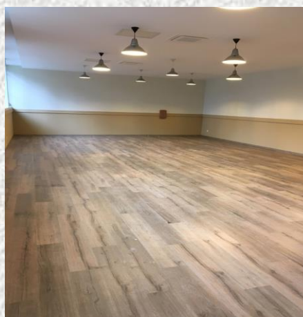
La salle de classe après travaux
