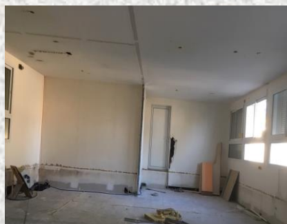
Le musée en construction
